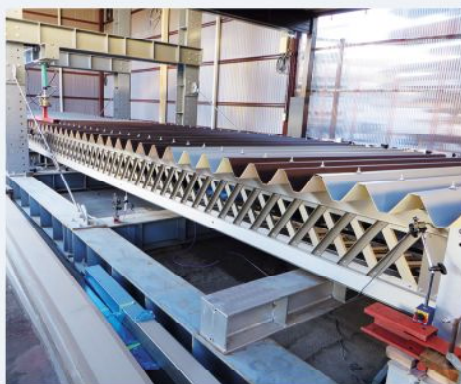
間口12m梁(屋根付き)強度試験の様子
